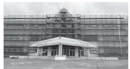
改修工事中の朝日小学校。エアコンも設置されます。
