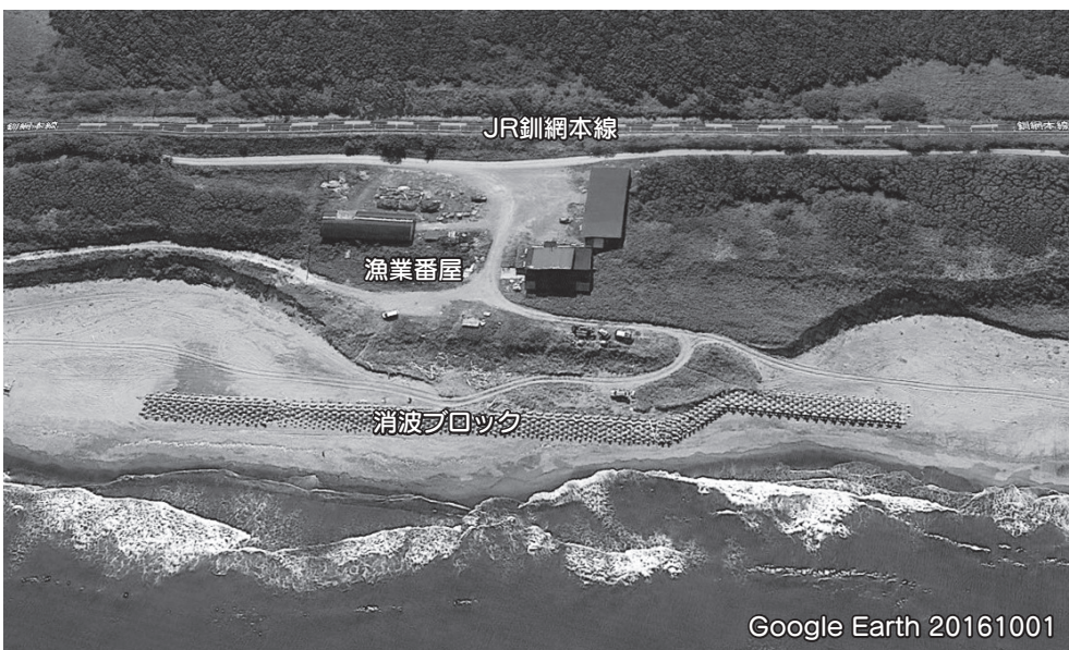
斜里川河口左岸地区海岸の浸食状況。漁業番屋のすぐ後ろに釧網本線が通っている。
